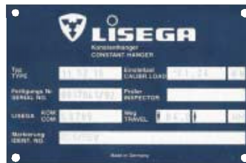
Placa de identificação com os dados de operação estampados
