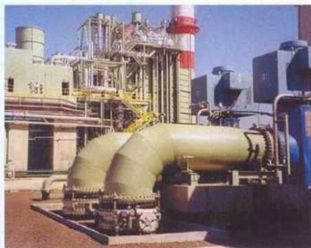
JUNTAS DE EXPANSÃO DE BORRACHA. Os corpos são fabricados em diversos elastômeros: Cloroprene, nitrílica, EPDM, EPDM sanitário, natural, hypalon, butílica e revestidas em PTFE. São fornecidas desde 1" até 80" de diâmetro.
